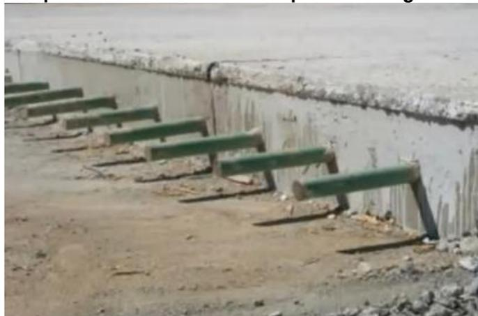
**Esquema 3. Dispositivo Tipo para colocación de Pasadores en Pavimentos de hormigón .**
