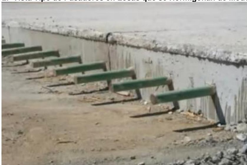
Imagen 2. Vista Tipo de Pasadores en Losas que se Hormigonan de Modo Intercalado.
