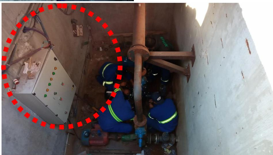
**Ilustración 8** Descarga e instalación de bomba nueva (Ing Juan Lamboglia)
