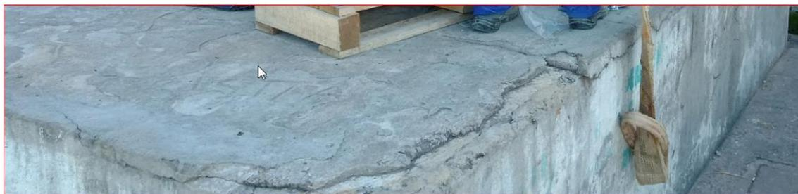
**Ilustración 9** Estado revestimiento cisterna (Fotografía Ing. Juan L.)
