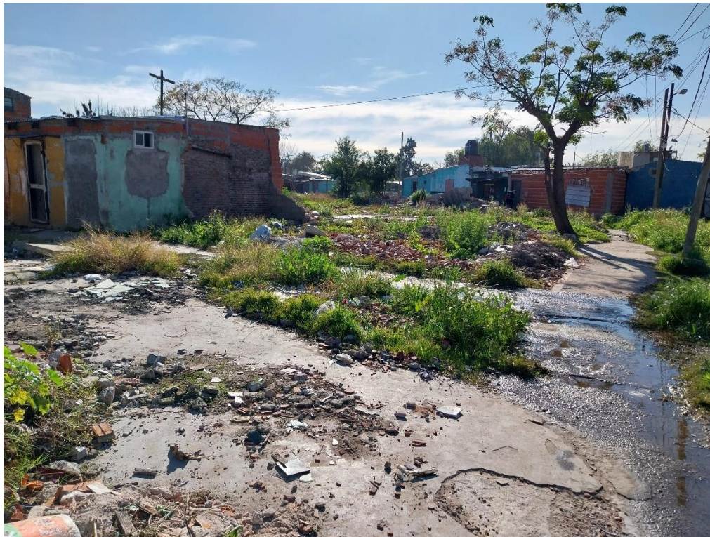
Imágen 4: Registro fotográfico apertura calle Chacabuco
