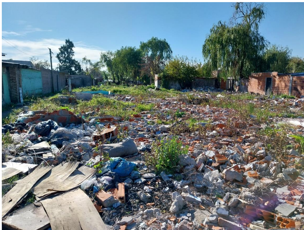
Imágen 3: Registro fotográfico apertura calle Chacabuco
